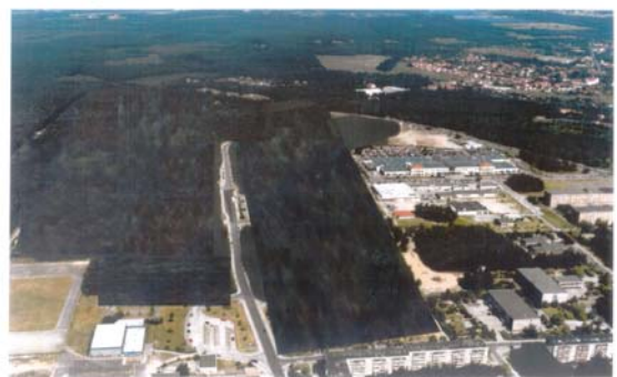
Beispiel Weißwasser – nach Rückbau
